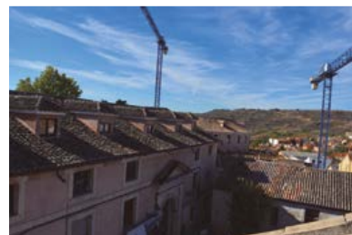
Obras del hotel balneario de 5 estrellas.
