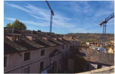
Obras del hotel balneario de 5 estrellas.
